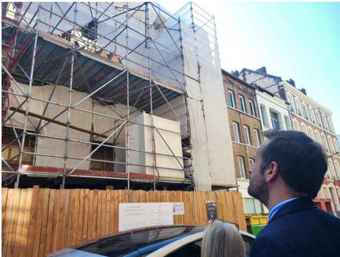
Le directeur général de la Fondation du patrimoine, Alexandre Giuglaris, s'est déplacé sur le chantier. - PND
