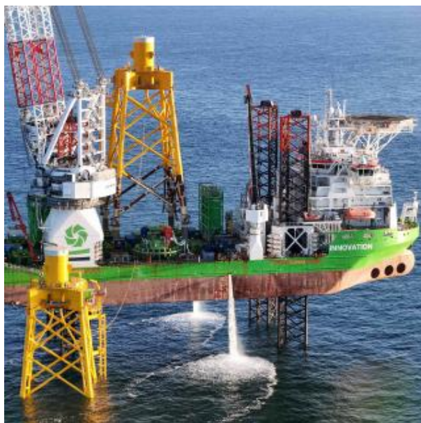
Les travaux du parc éolien en mer Dieppe/Le Tréport ont repris, au large
