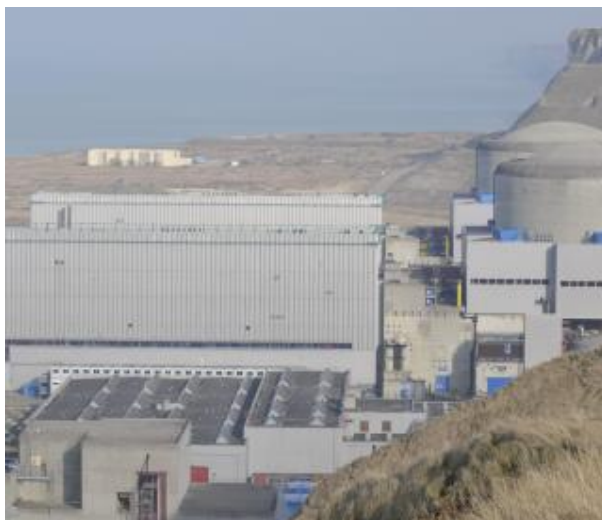
Le réseau routier doit s'adapter au chantier de l'EPR de Penly
