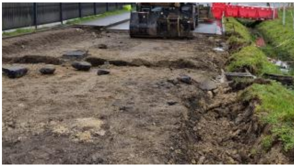
Mesnil-Raoul : les travaux de remise en état de la RD 294 s'achèveront en mars
