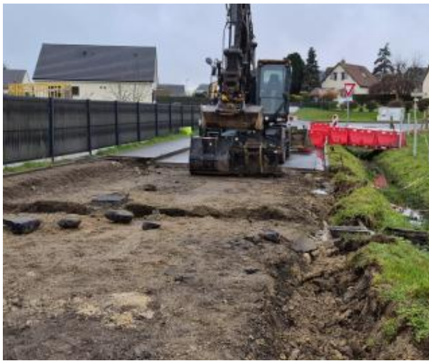
Mesnil-Raoul : les travaux de remise en état de la RD 294 s'achèveront en mars
