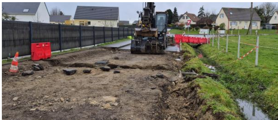
Mesnil-Raoul : les travaux de remise en état de la RD 294 s'achèveront en mars
